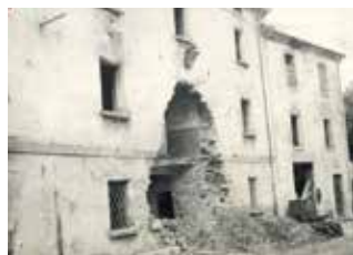
Casa distrutta, Toano
